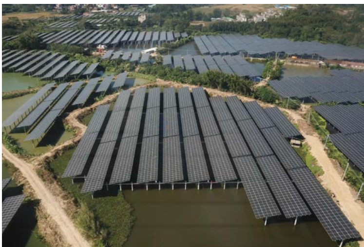
2. ábra: Egy 150 hektáros halastó rendszeren felépített PV energiatermelő telep Kína Guandong tartományában Gangmei város mellett (Forrás: PV Magazin, Fotó: Jetion Solar)
