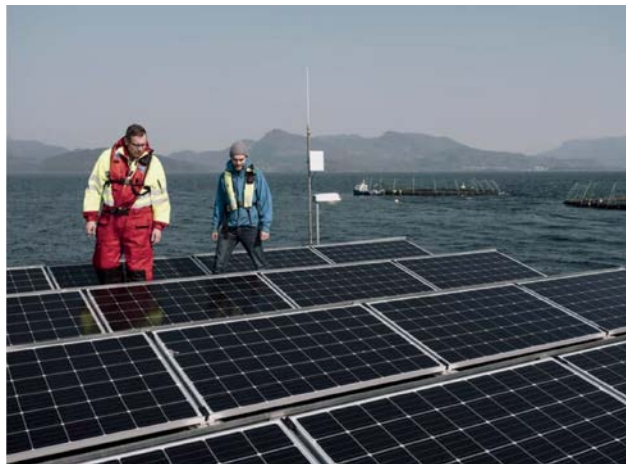
6. ábra: Energiatermelő PV modulok egy takarmány ellátó uszály fedélzetén a norvég Grieg Seafood Rogaland lazactermelő gazdaságban (Forrás: https://griegseafood.com/ )
